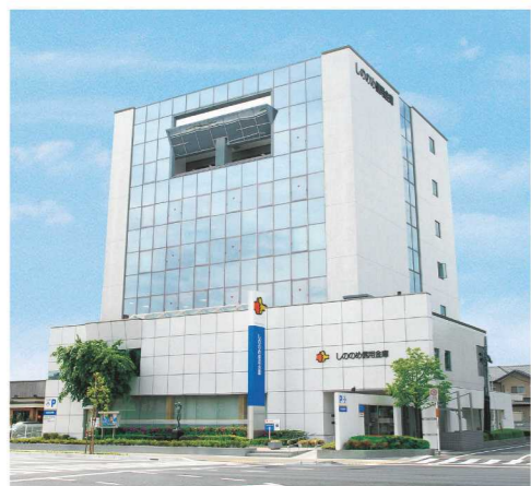
高崎支店ビル
